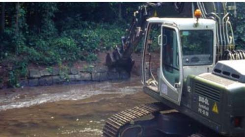
Das Entfernen des Böschungspflasters fördert die Eigenentwicklung an diesem Mittelgebirgsbach.
