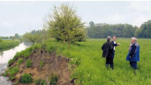
Aufzehren einer flachen Verwallung mit eigendynamischer Profilaufweitung. Das Belassen naturnaher Strukturelemente erforderte ausgiebige Diskussionen mit den Flächennutzern.
