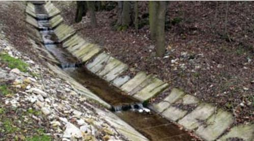
Eine eigendynamische Verlagerung ist an diesem Bergbach nicht möglich. Falls jedoch Betonschalen und Abstürze entfernt werden, bieten sich ungeahnte Möglichkeiten einer naturnahen Entwicklung.
