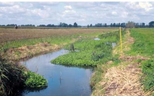
Das Bild zeigt ein regelprofiliertes Flachlandgewässer, das seit Anfang der 1990er Jahre wechselseitig mit dem Mähkorb gekrautet wird, kurz nach der Unterhaltung. Mit Überspringen immer gleicher Abschnitte in etwa 15 Metern Länge hat sich ein interessantes Vegetationsmosaik ausgebildet, das die Strömungsverhältnisse deutlich belebt.
