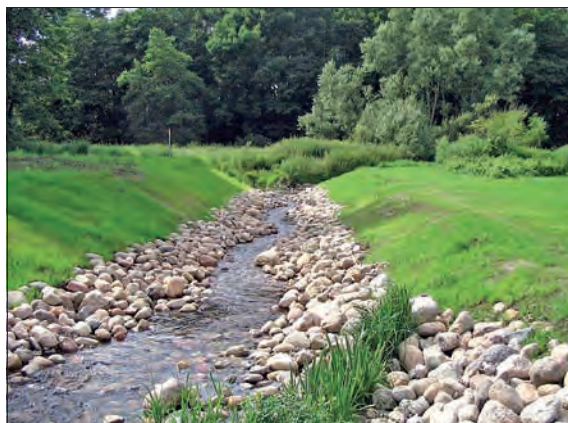
Rückbau eines Sohlabsturzes an der Schwartau und Bau einer Sohlgleite (Foto: WBV OH)
