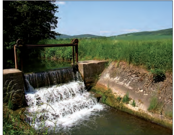
Querbauwerke wie das Wehr in Hildburghausen (TH) hindern Fische und andere Wasserorganismen an ihren Wanderungen (Foto: DVL)
