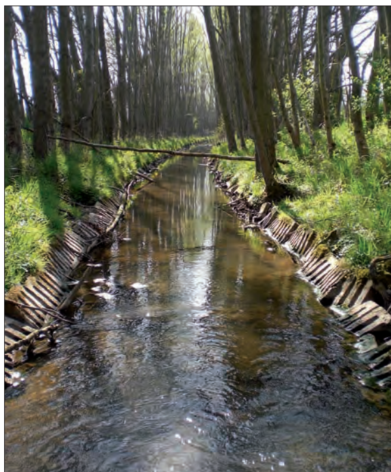
Uferbefestigungen (Foto: LPV Thüringer Grabfeld e. V.)
